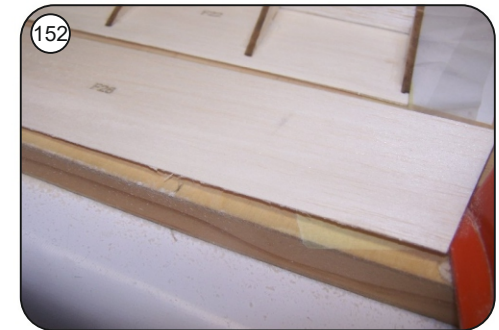
152 Hinterkante von oberer Beplankung F26 schräg anschleifen.
